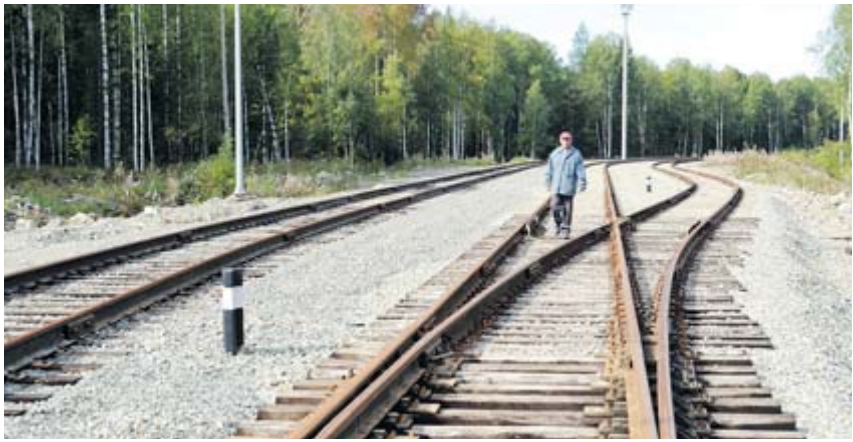
Железнодорожные пути на станции Карьер
